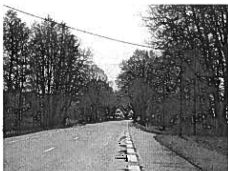
Figure 6 : l'entrée Sud de Surbourg
