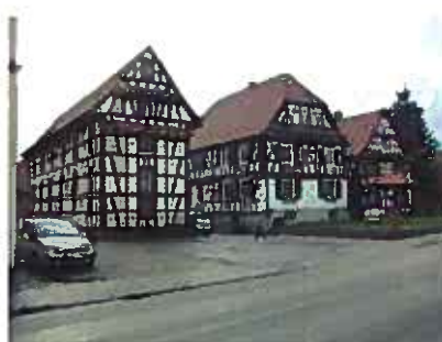
Photo 4 : Grange-séchoir à tabac à Surbourg
