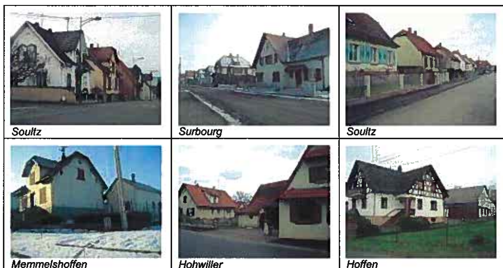
Photo 14 : Exemples de bâti de Faubourg structuré (rapport à la rue)
