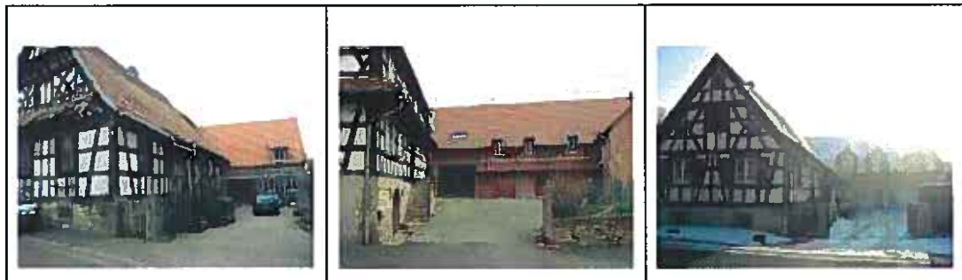
Photo 10 a, b et c : exemples de réhabilitation de granges en logements
