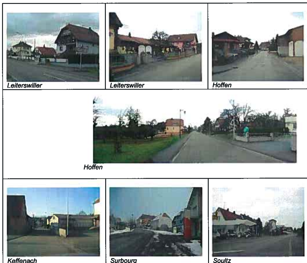
Figure 39 : Constructions caractérisant le bâti de faubourg, déstructuré
